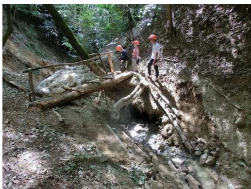
R3.10.6 杉谷川仮橋取付
