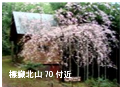
はせがわのトイレ棟
