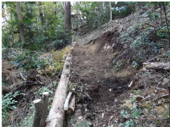
橋を架け修復
